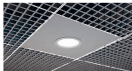
Установка светильника с переходником 600x600
