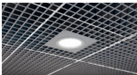
Установка светильника с переходником 300x300
