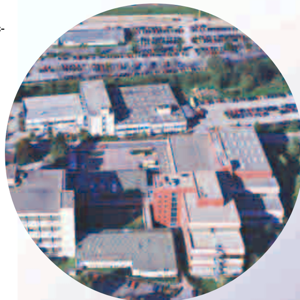
Производственный центр по изготовлению приборов давления и уровня в г.Маульбург, (Германия).
